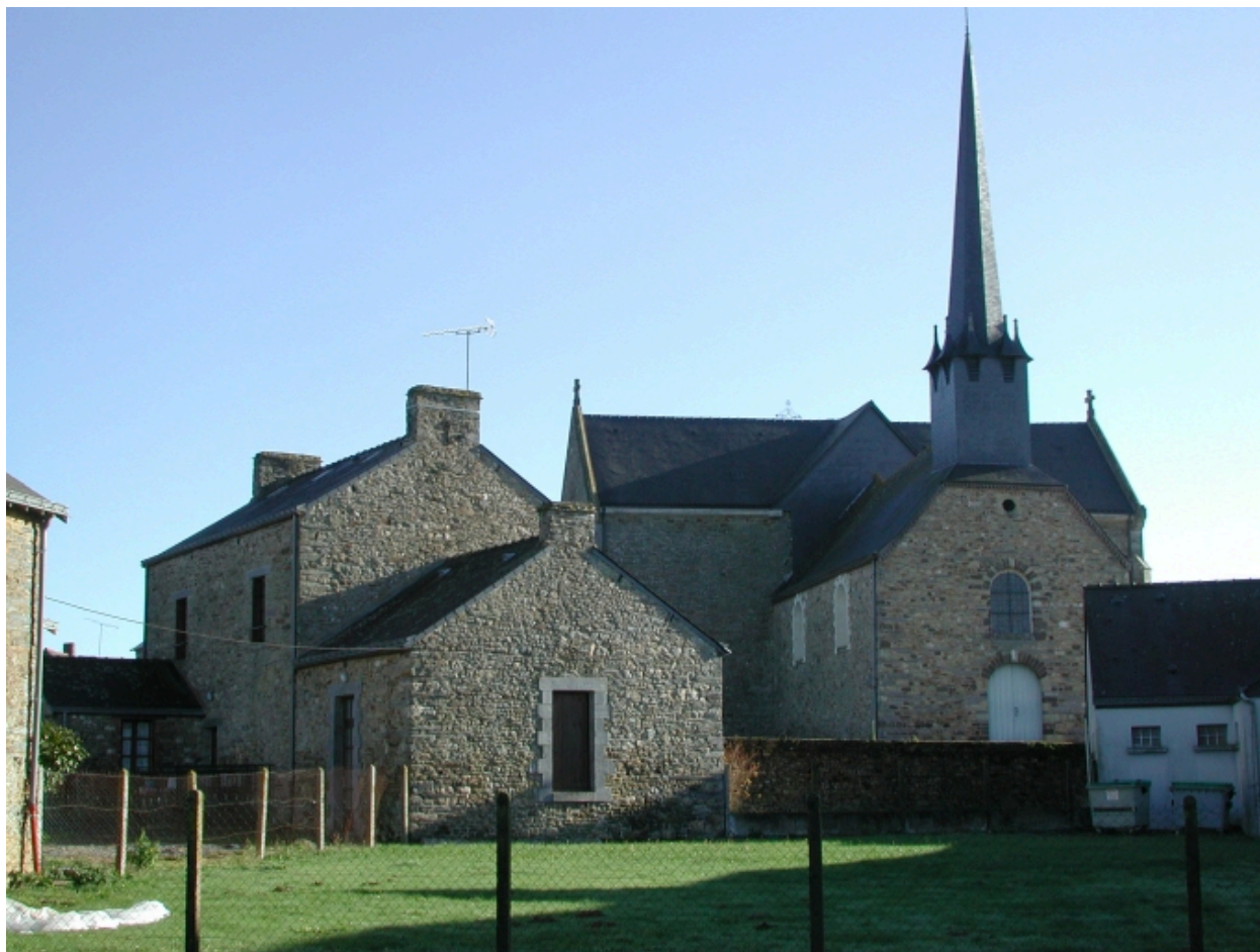
Vue de situation ouest
