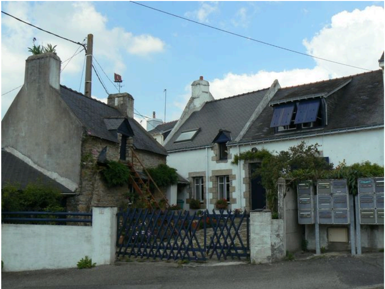
Vue générale de la maison de pêcheur du 18 rue de Cadouarn
