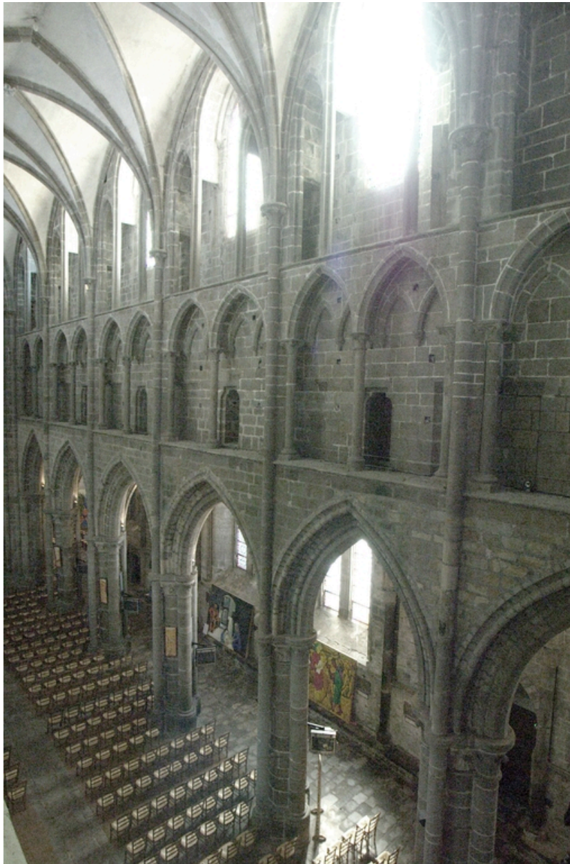
Intérieur, élévation sud de la nef depuis le nord-ouest
