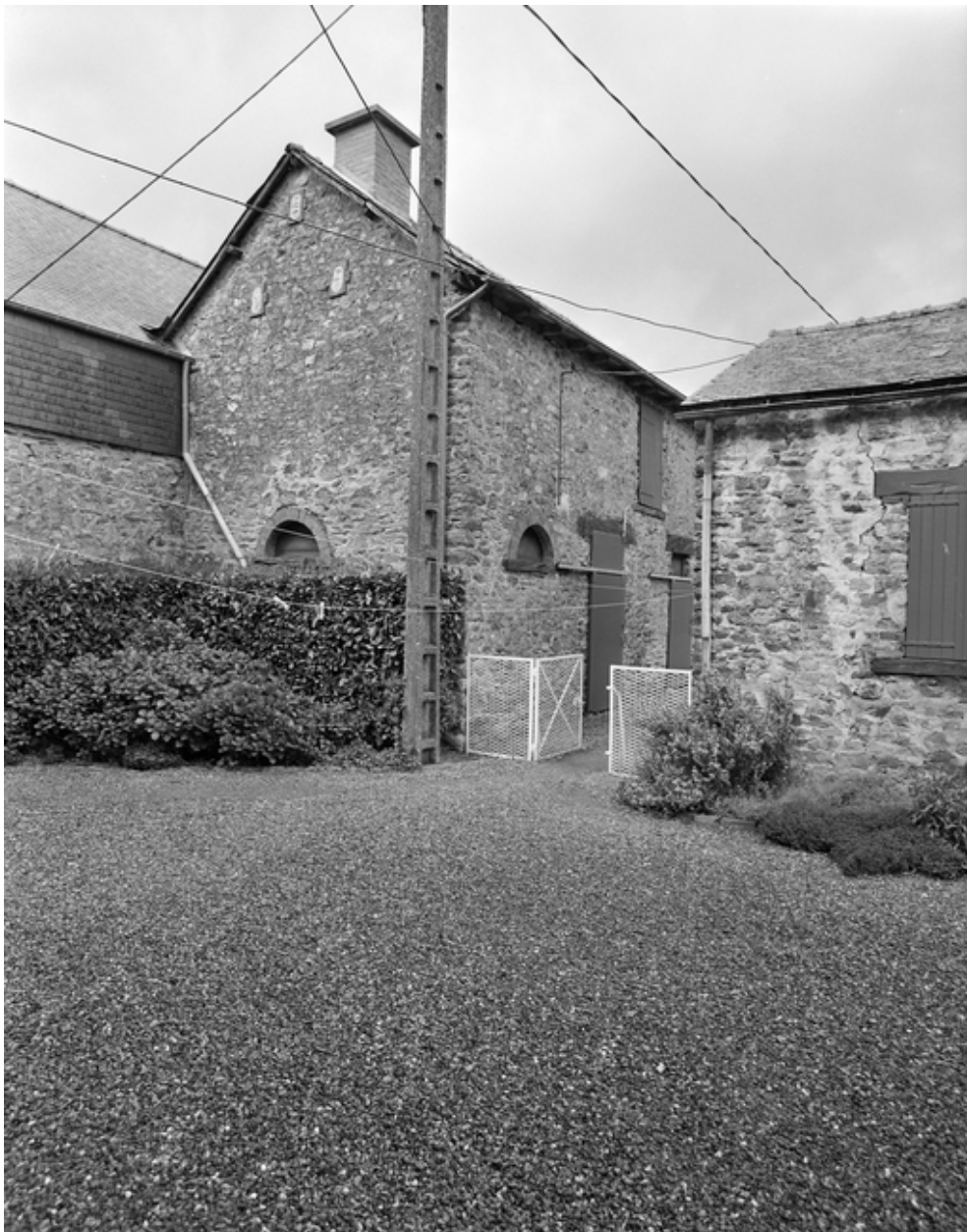
Elévation nord des communs
