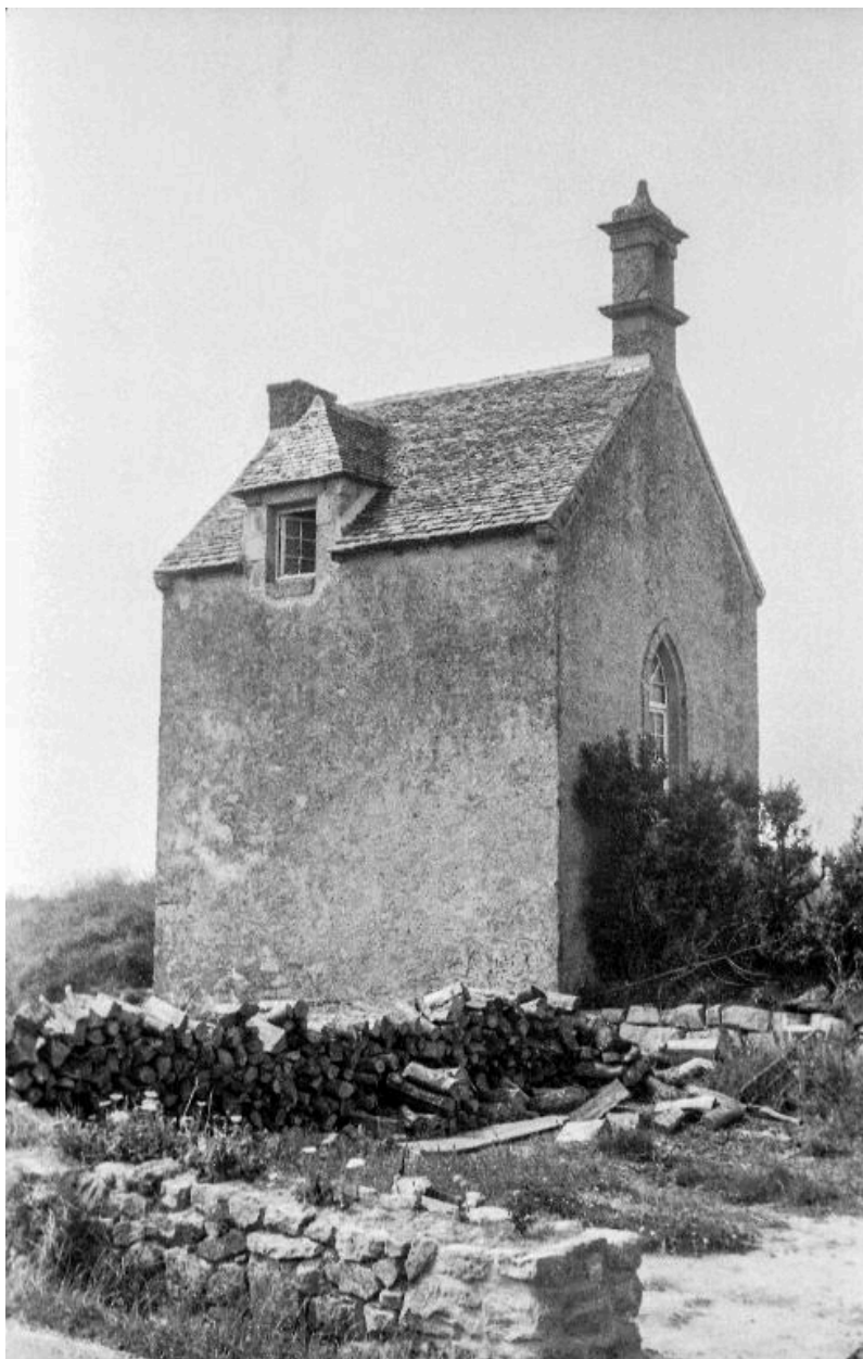
Barrage : maison vue du nord-est (état en 1972)
