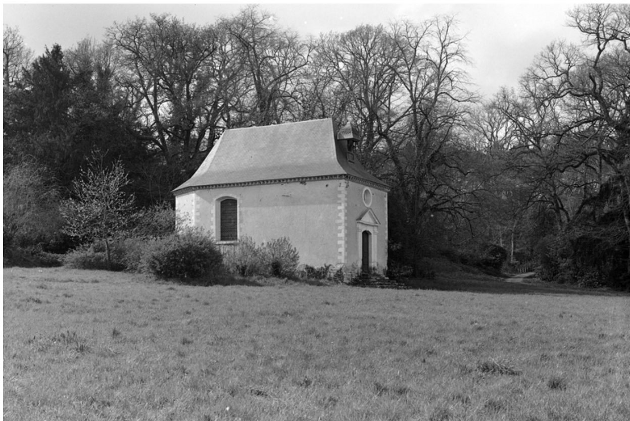
Vue générale de la chapelle.
