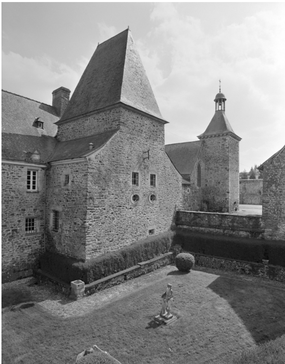
Vue ouest de la tour d'escalier et du clocher de la chapelle.
