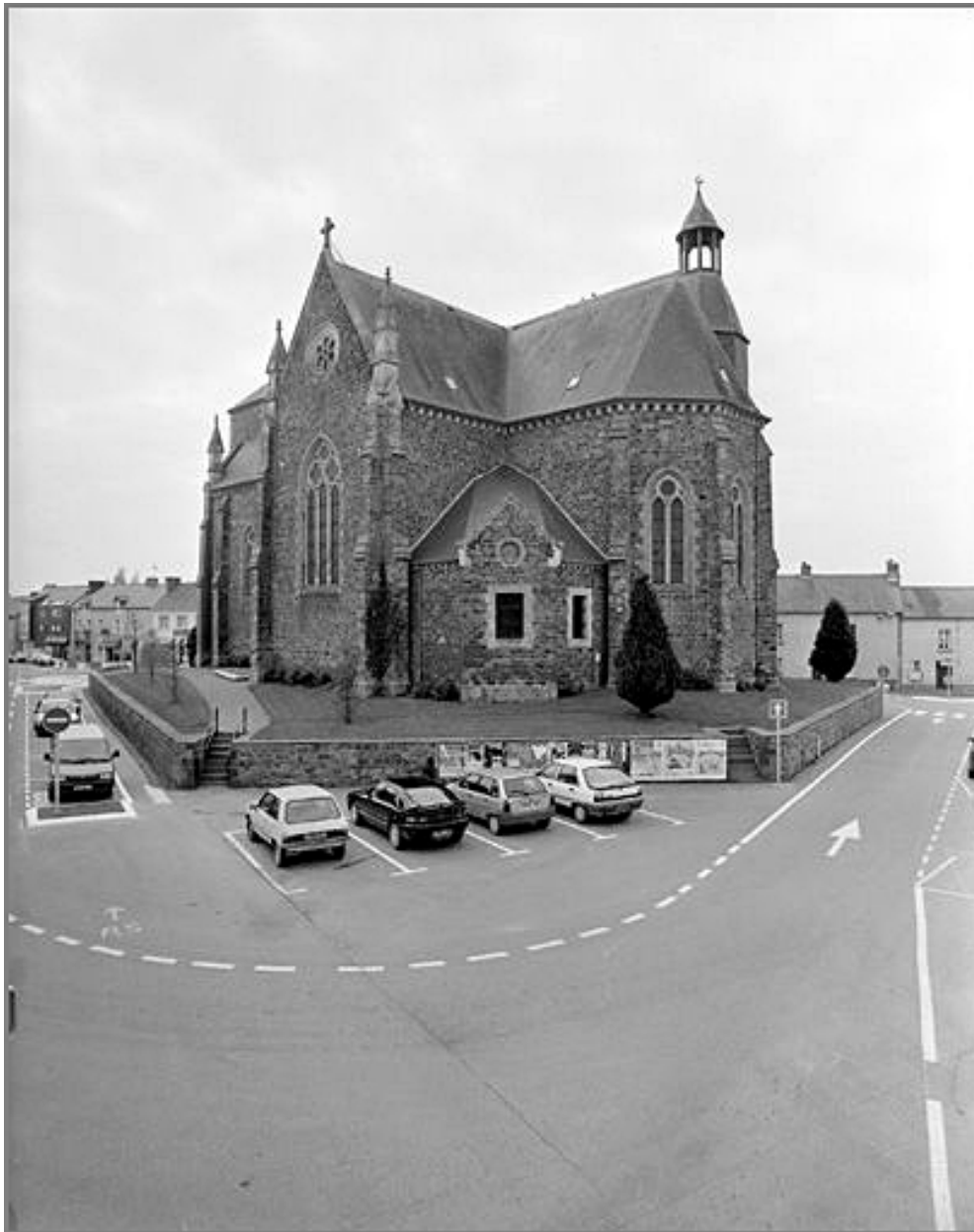
Elévation Nord-Ouest : vue générale
