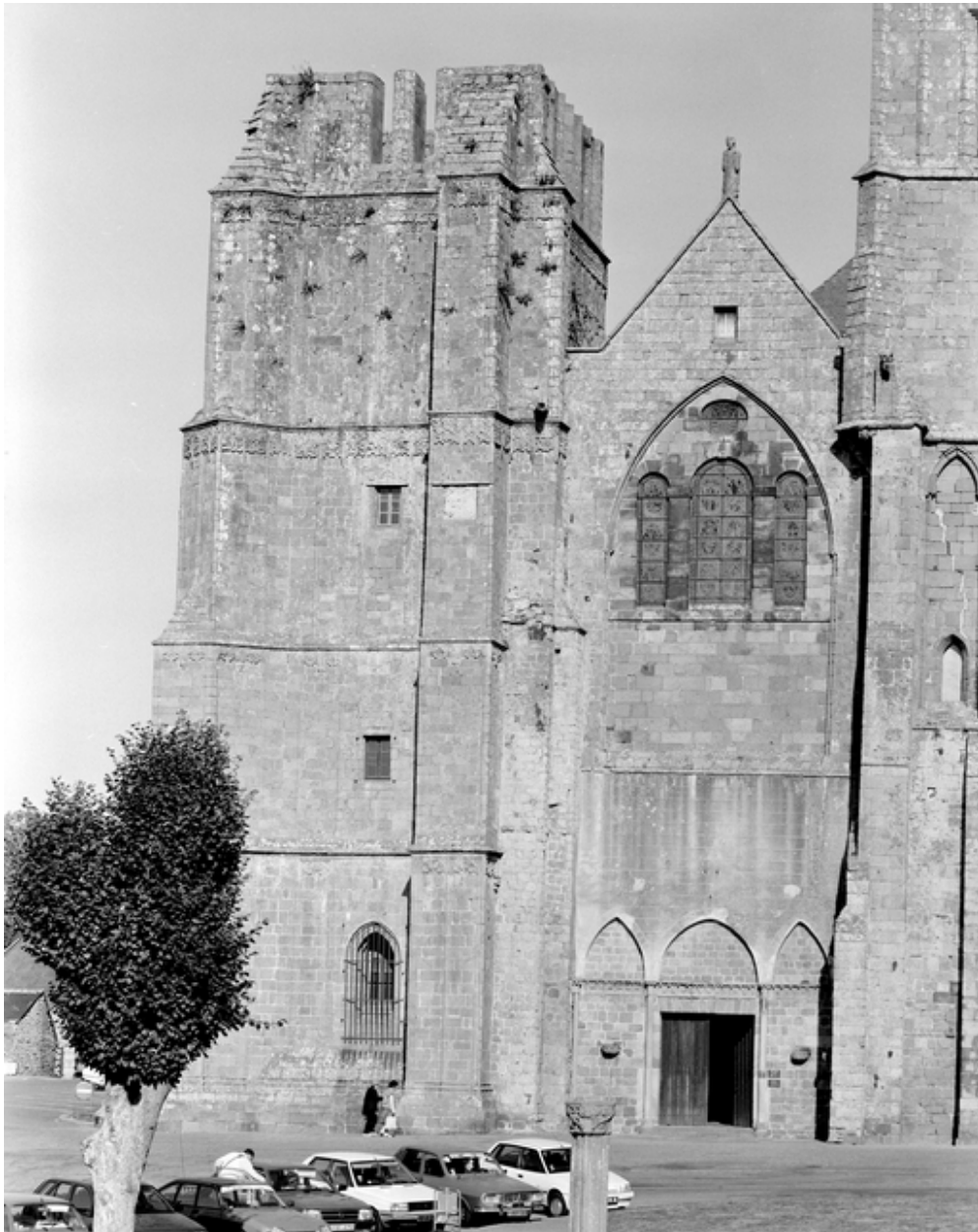
Tour occidentale nord : vue générale
