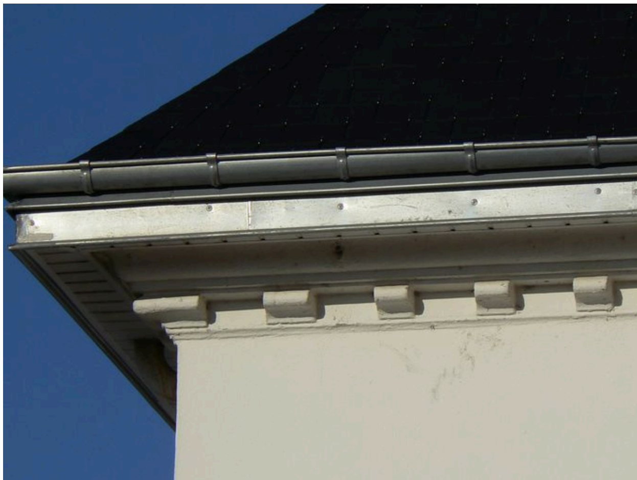
Denticules décoratifs de la corniche extérieure de la villa 3 boulevard des Plages
