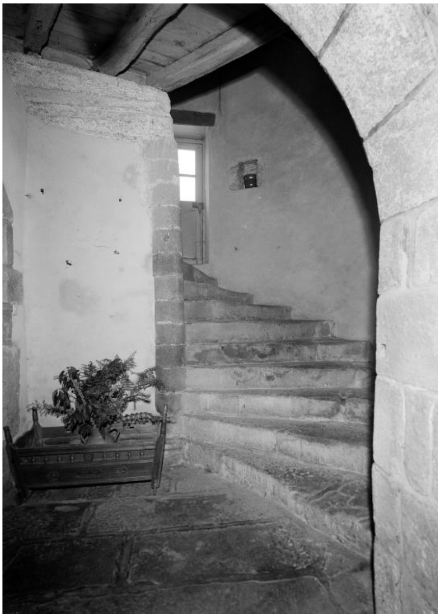
Départ de l'escalier sur la façade nord, à l'extrémité nord du couloir d'entrée
