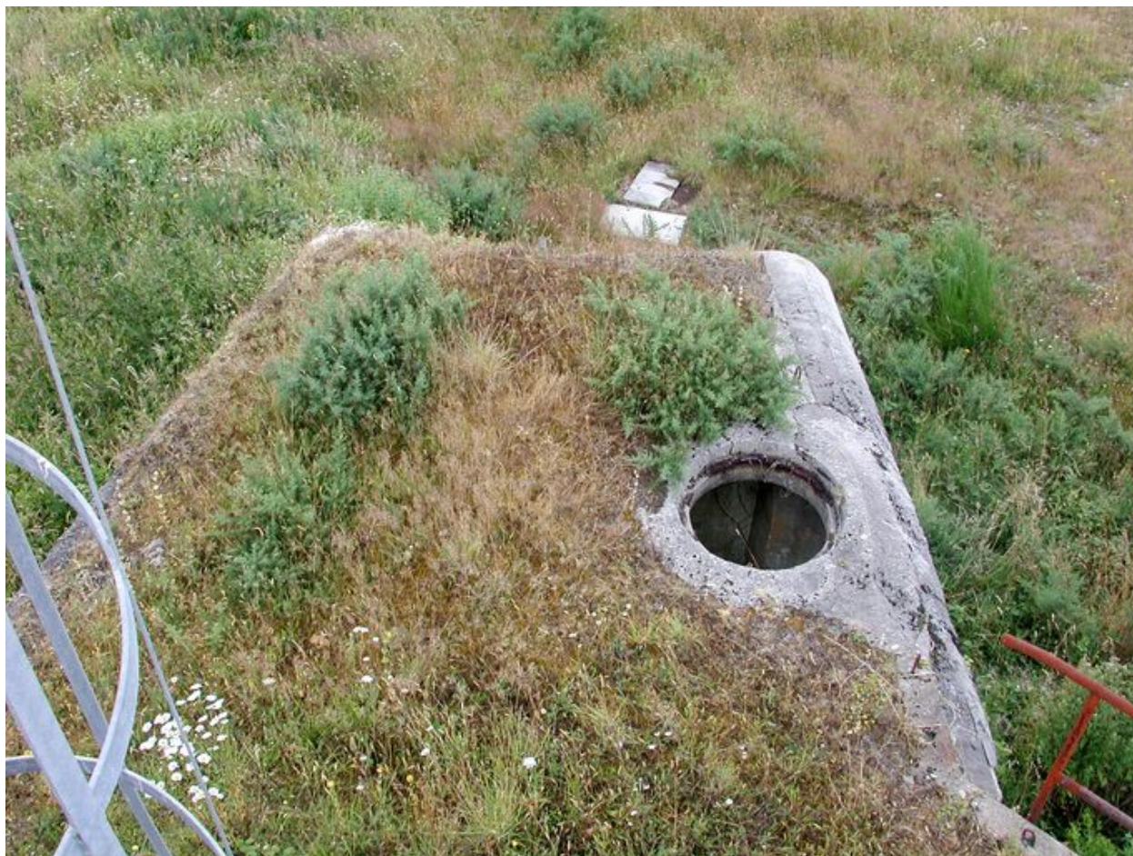
Vue du poste d'observation (état en 2003)
