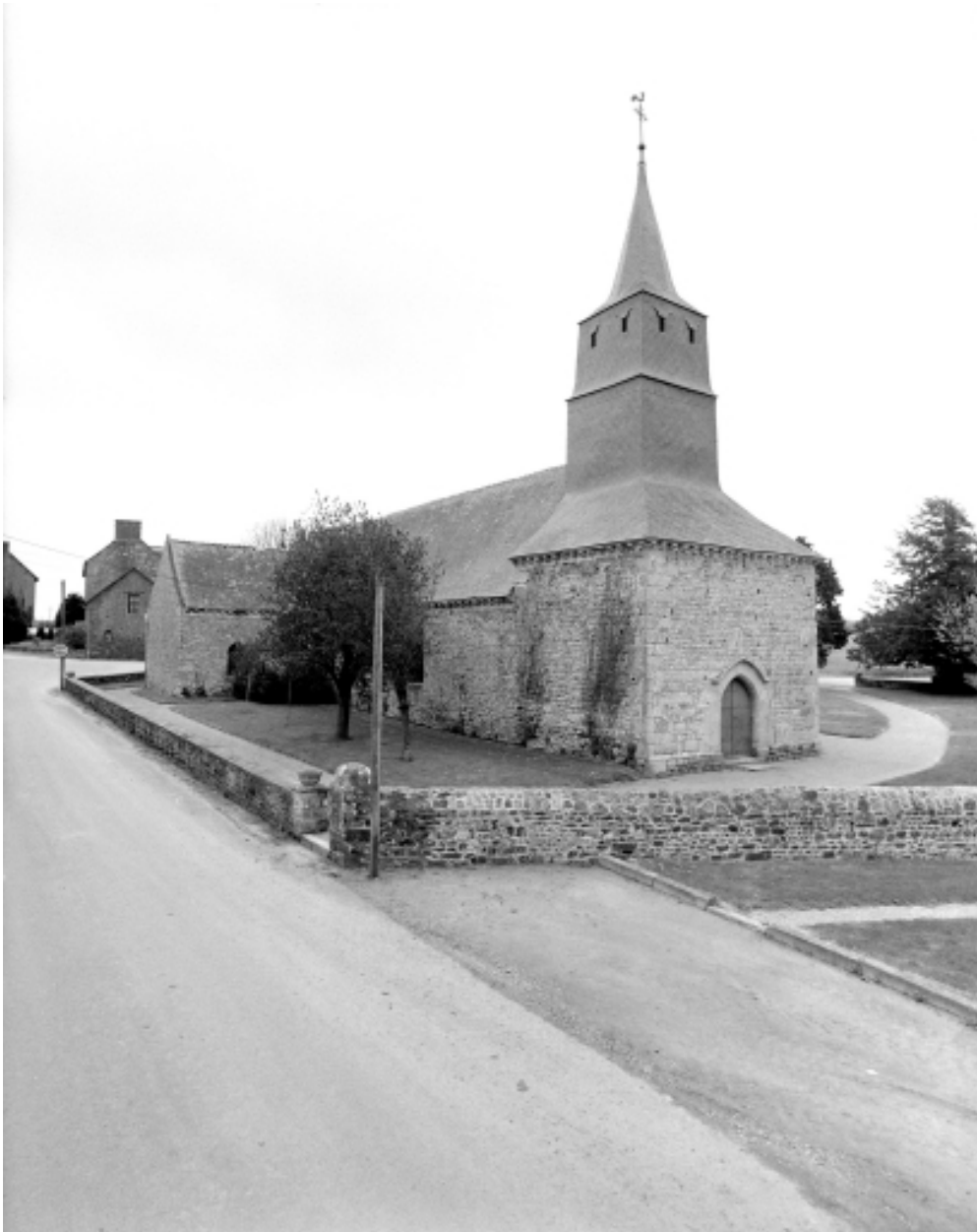
Elévation Nord-Ouest : vue générale
