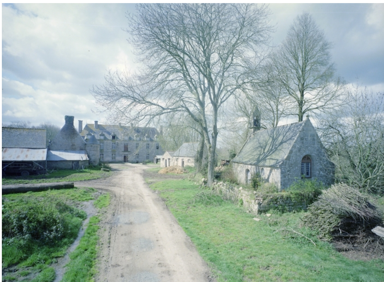
Vue de situation de la façade principale
