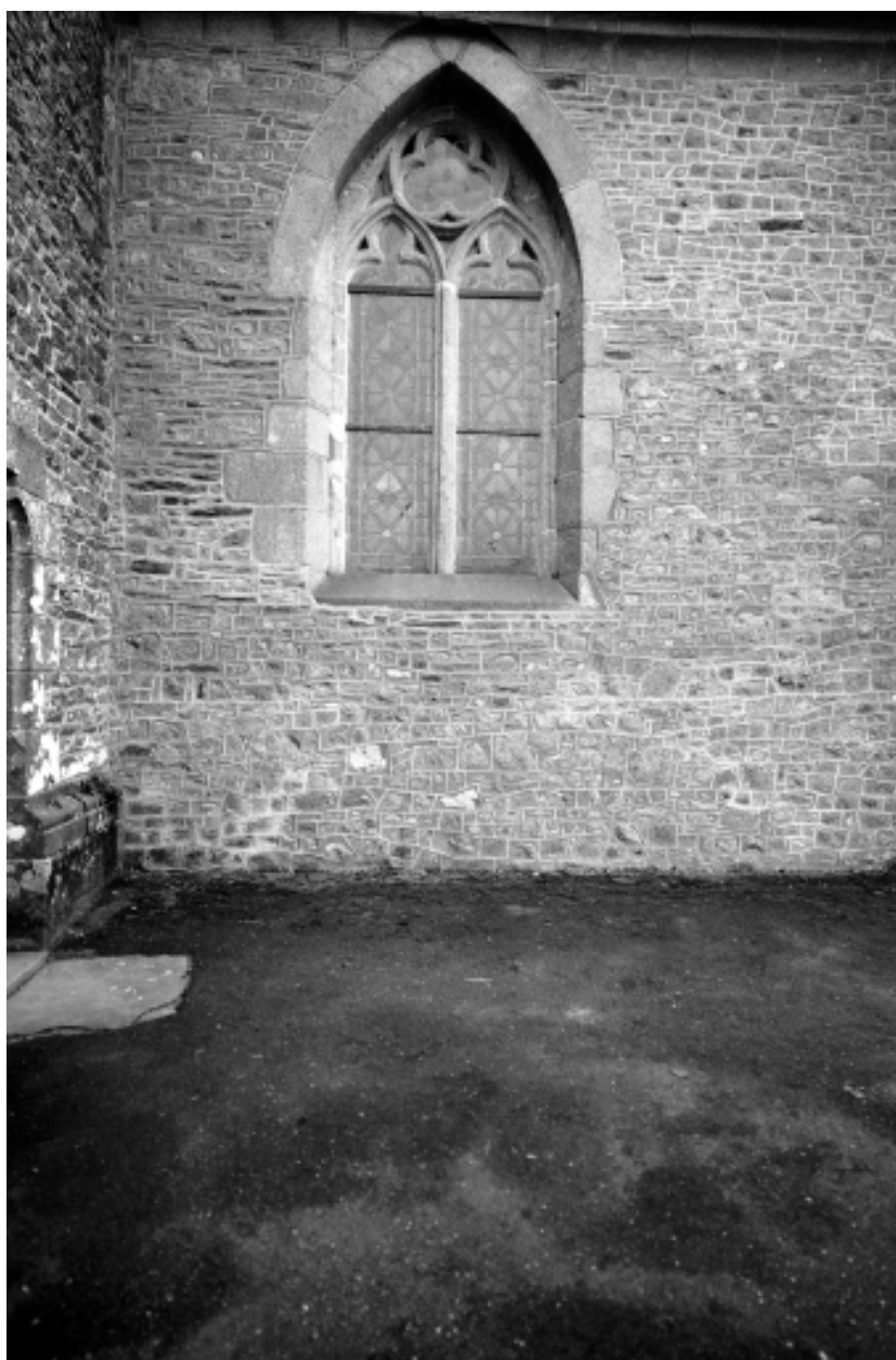
Façade Nord, nef, détail fenêtre.
