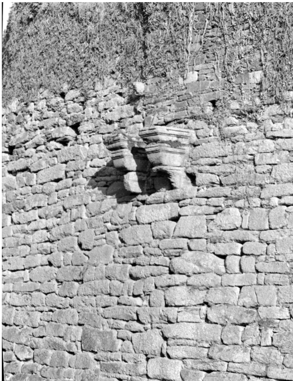
Chemise nord-est, détail.
