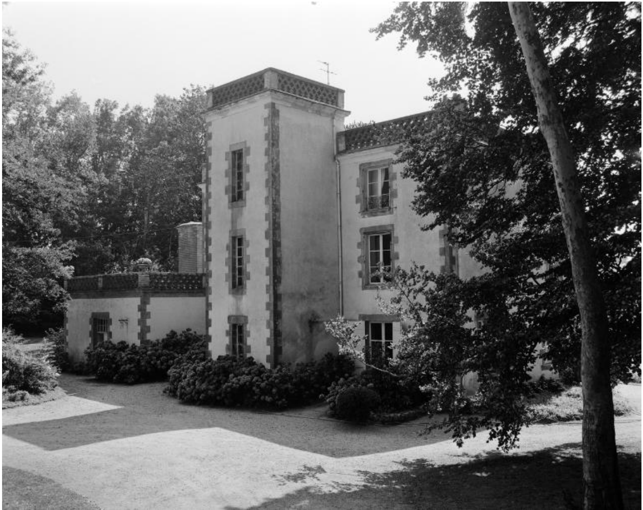
Logis, élévation nord, vue prise de l'ouest.
