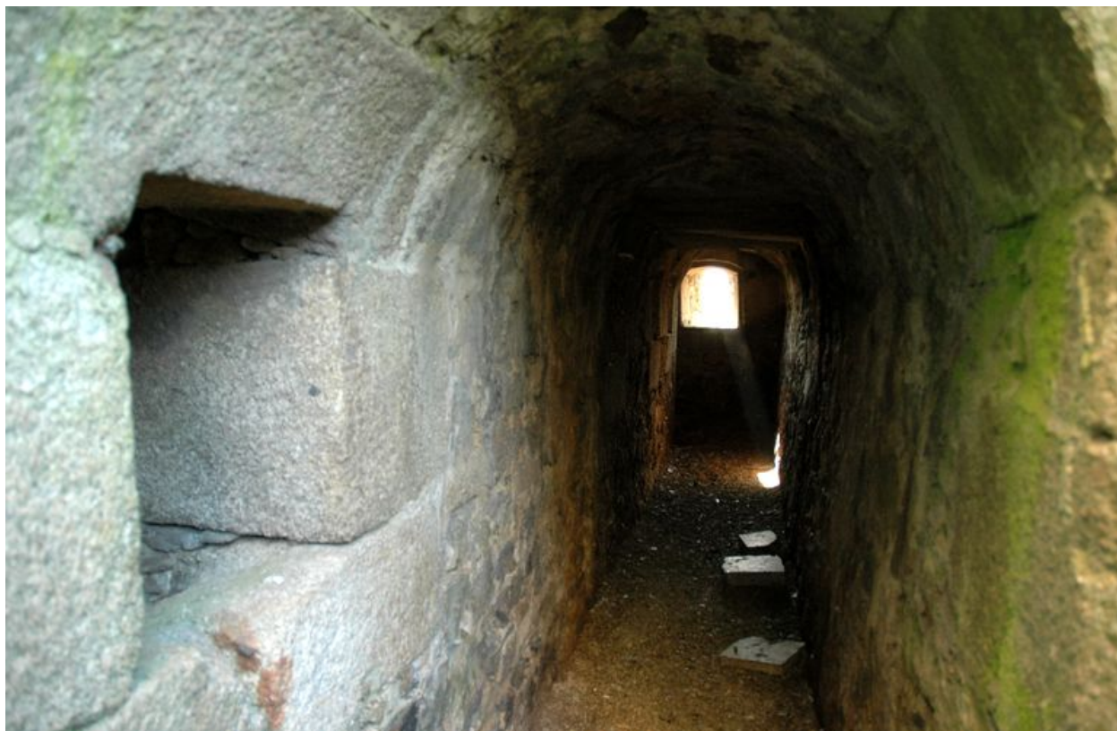
Vue de la galerie de fusillade
