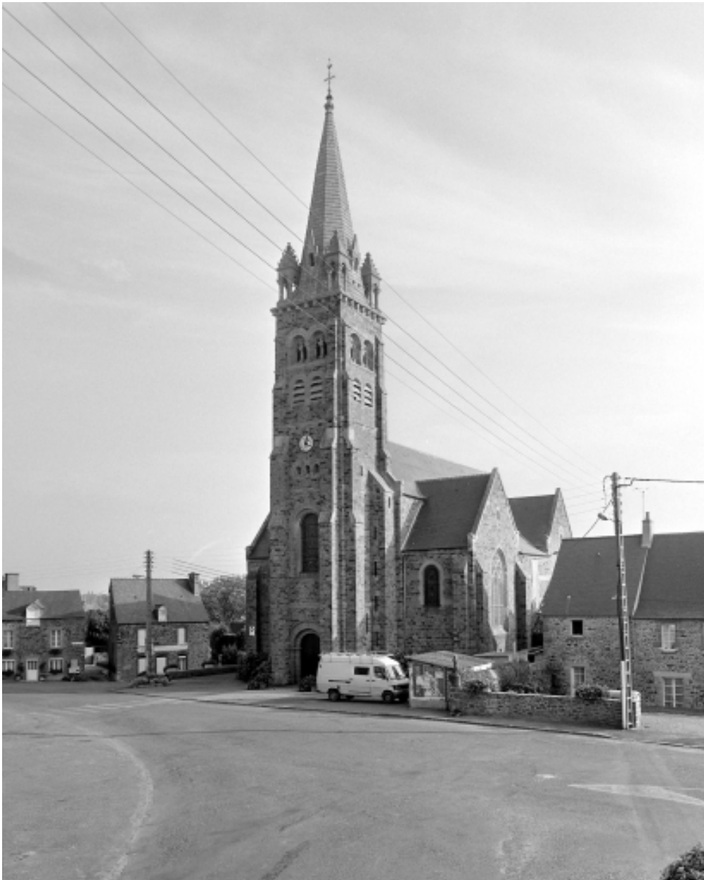
Elévation nord-ouest : vue générale
