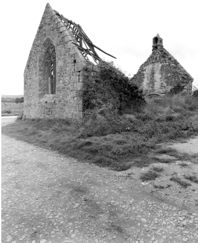
Vue générale face nord
