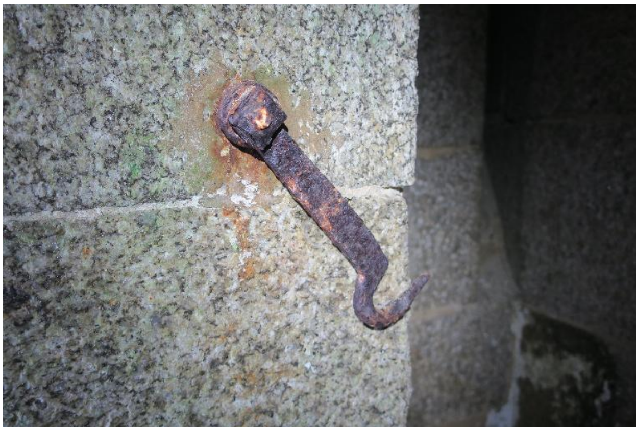
Le Palais, pointe de Taillefer, corps de garde crénelé, crochet de maintien du pont-levis.
