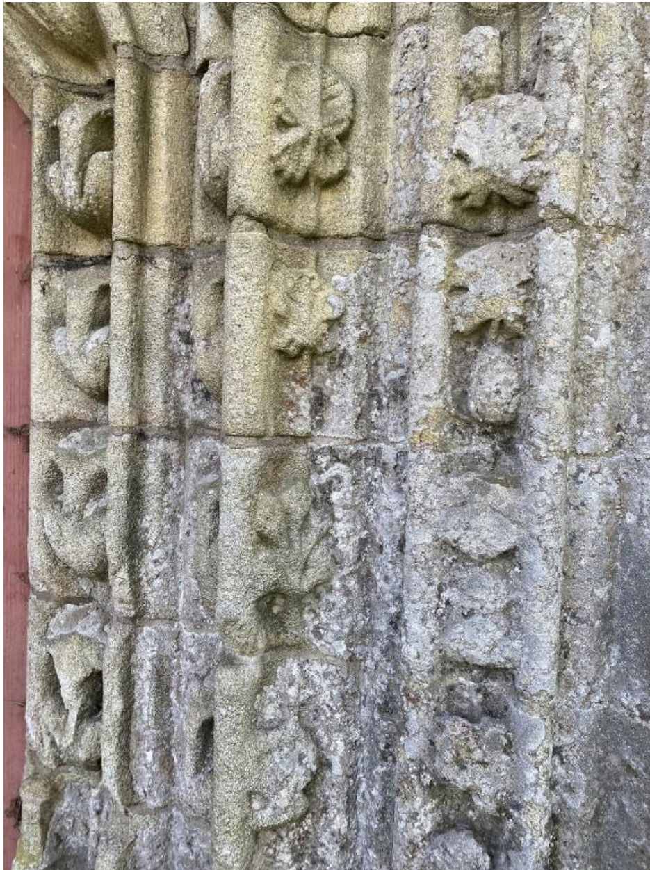
Portail ouest, détail
