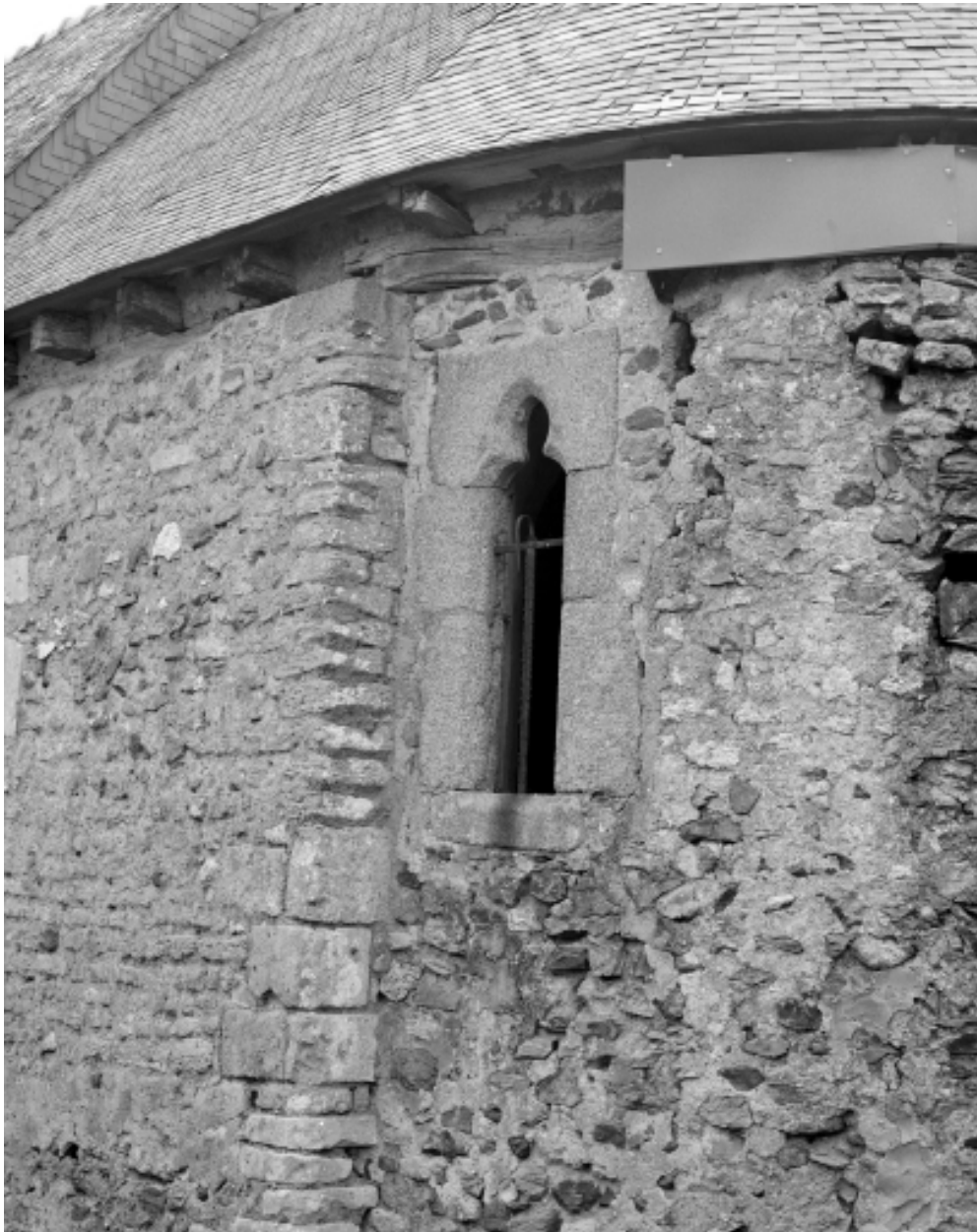
Détail ; fenêtre sud est
