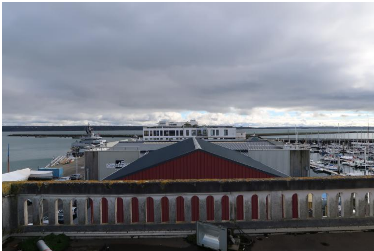
Vue de la jetée ouest depuis l'ancien bureau du port
