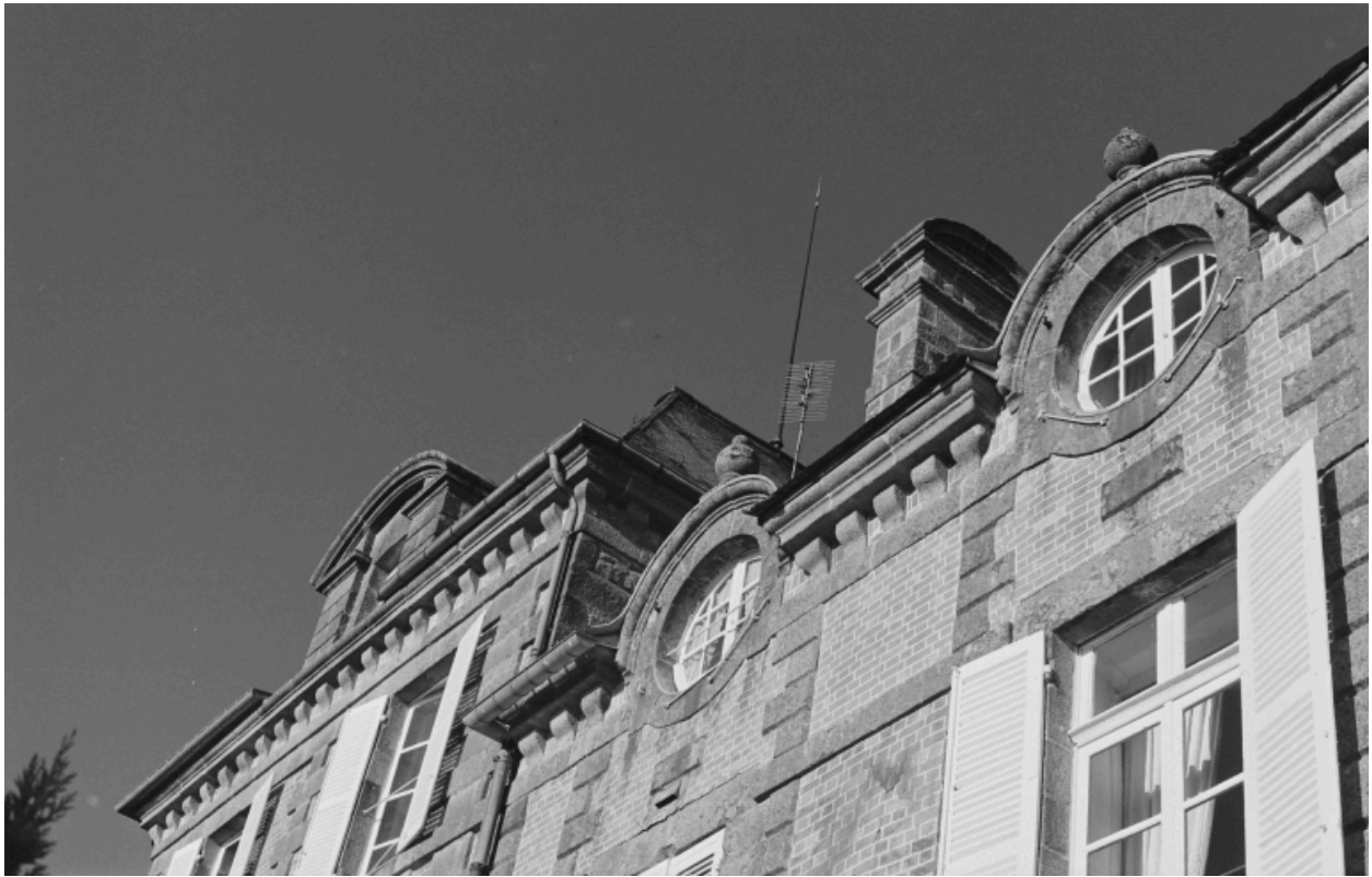
Détail de la corniche, façade nord
