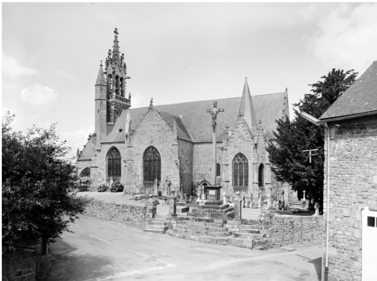
Elévation sud, partie est : vue générale
