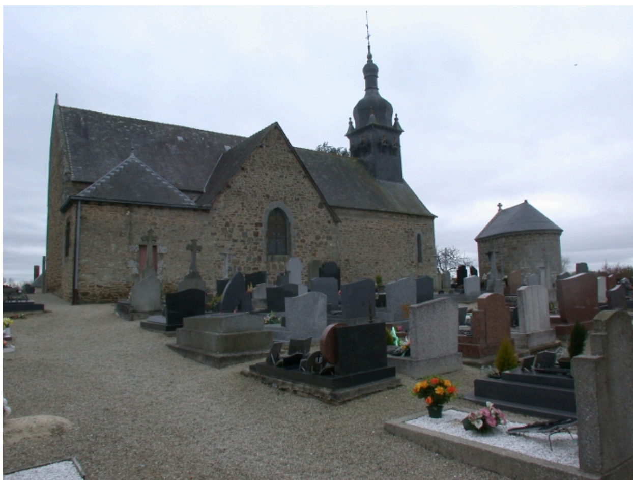
Façade Sud, vue actuelle
