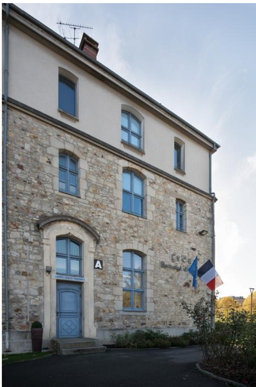
L'entrée du lycée (bâtiment A, façade nord).
