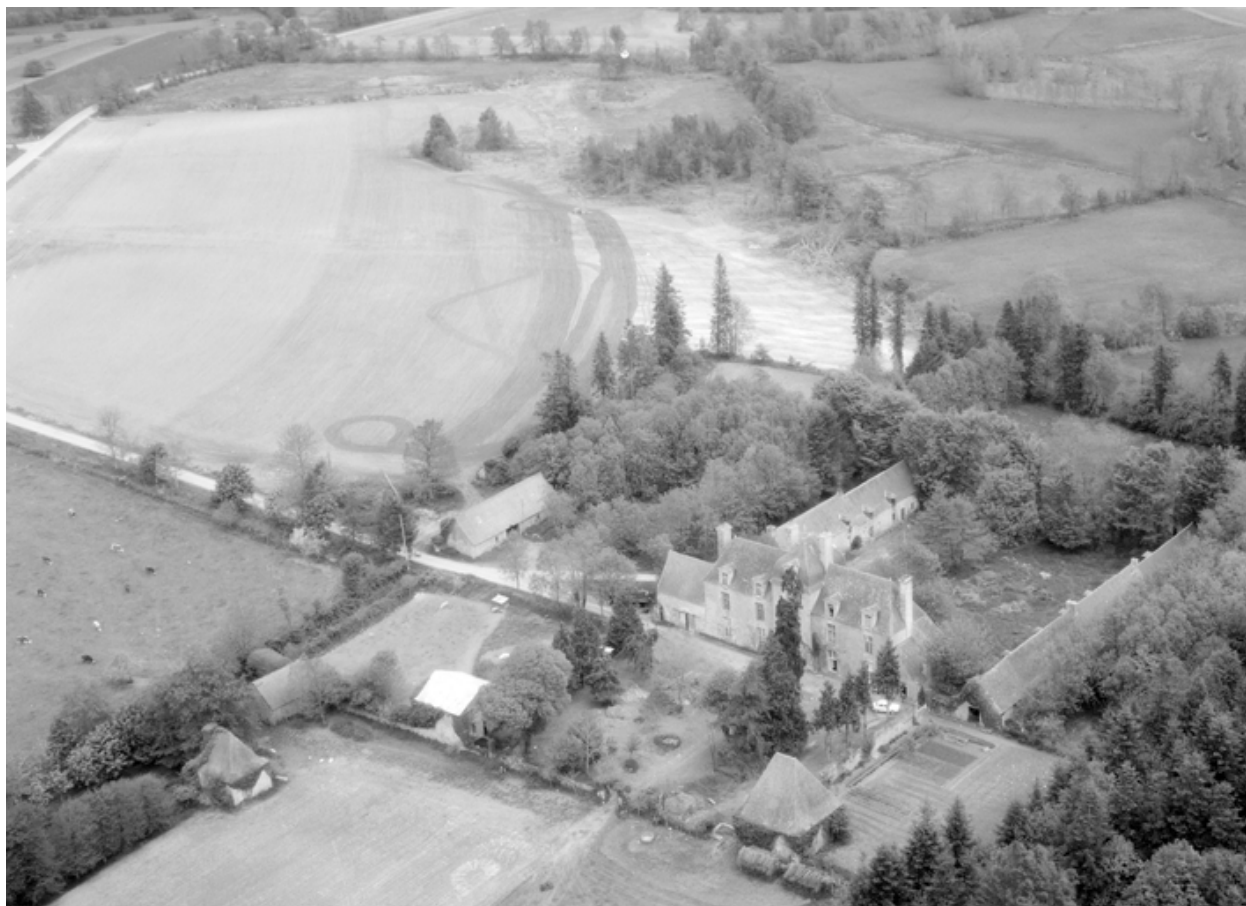
Vue aérienne prise du sud-est, état en 1969
