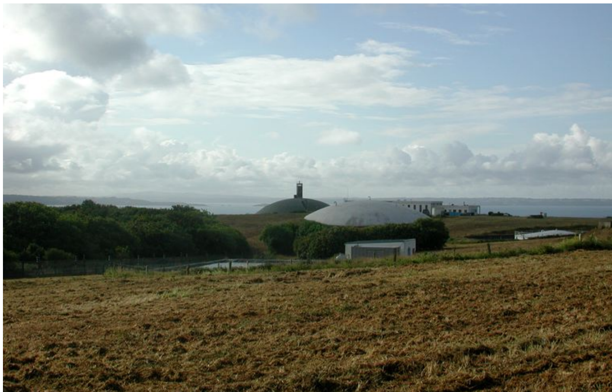
Vue générale du parc à carburant de Maison Blanche
