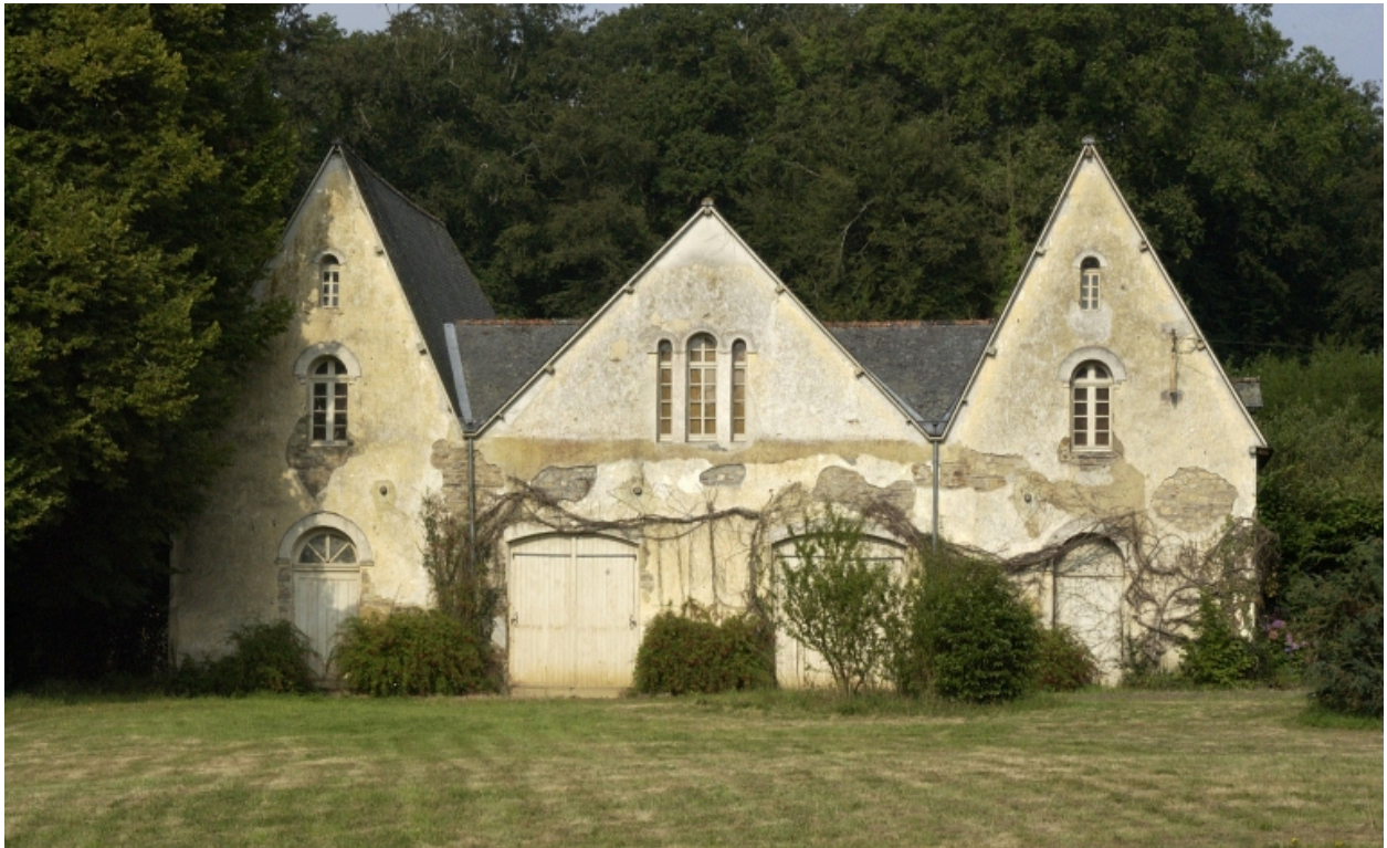
Les communs : vue générale sud-est
