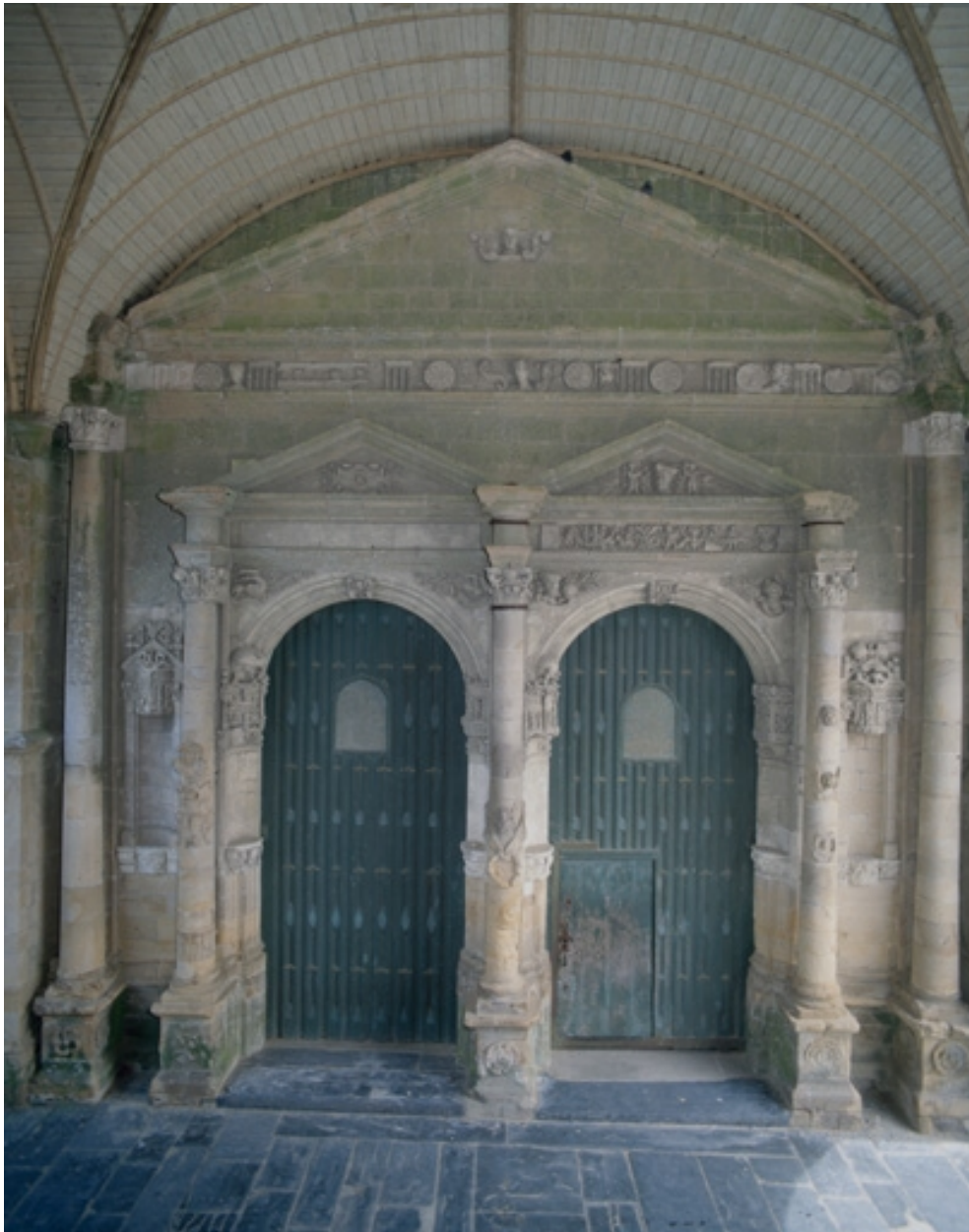
Porche ouest, porte principale
