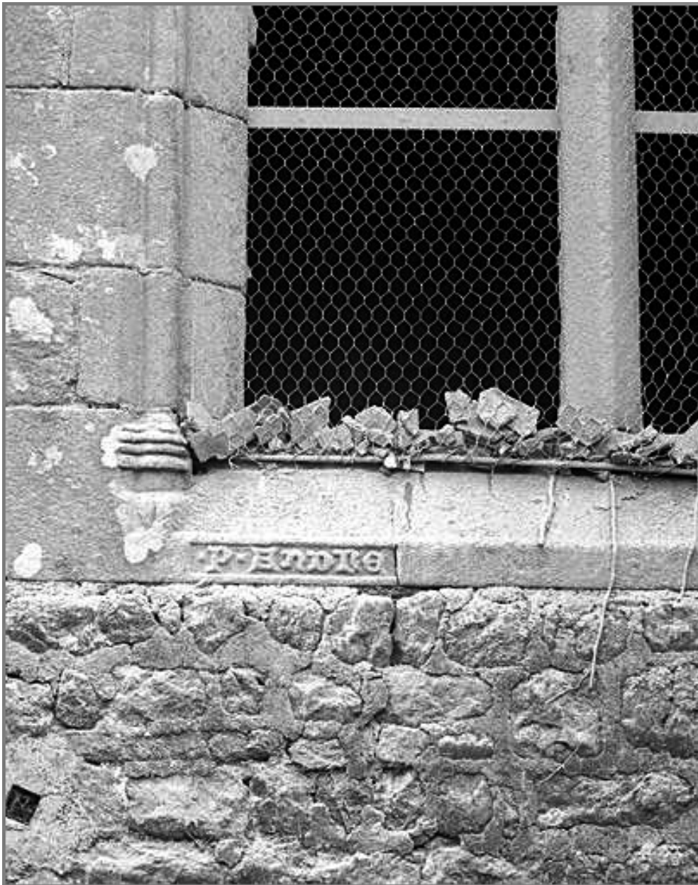
Elévation sud, partie centrale, fenêtre : détail de l'inscription
