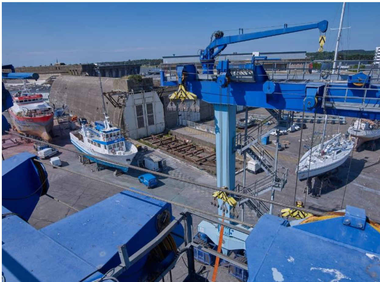
Vue de situation depuis le sommet de l'élévateur à bateaux de l'aire de réparation navale
