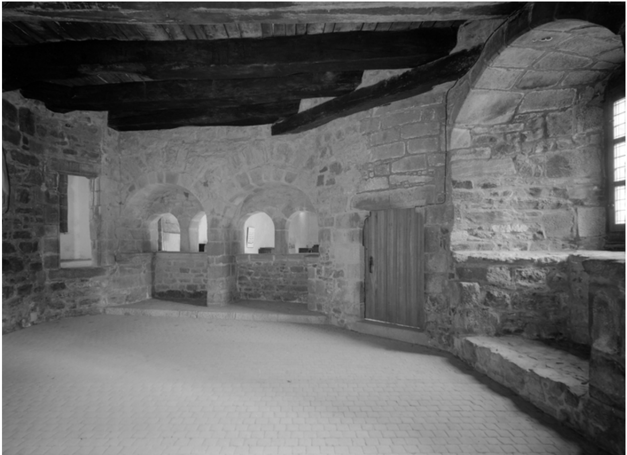
Vue de la cuisine : mur de refend (état en 1974). A gauche, porte de la tour (dotée d'un passe-plat vers la salle basse) ; au centre, ensemble de quatre passe-plats ; à droite, porte donnant sur la cage de l'escalier en vis et fenêtre
