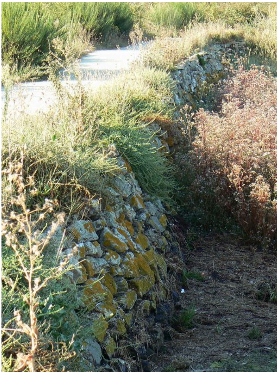
Digue-route dite le Pont Lisse
