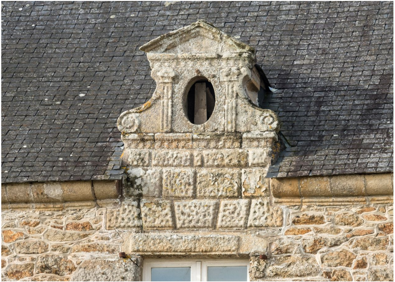
Détail d'une lucarne ornée de pilastres et volutes, coiffée d'un fronton triangulaire
