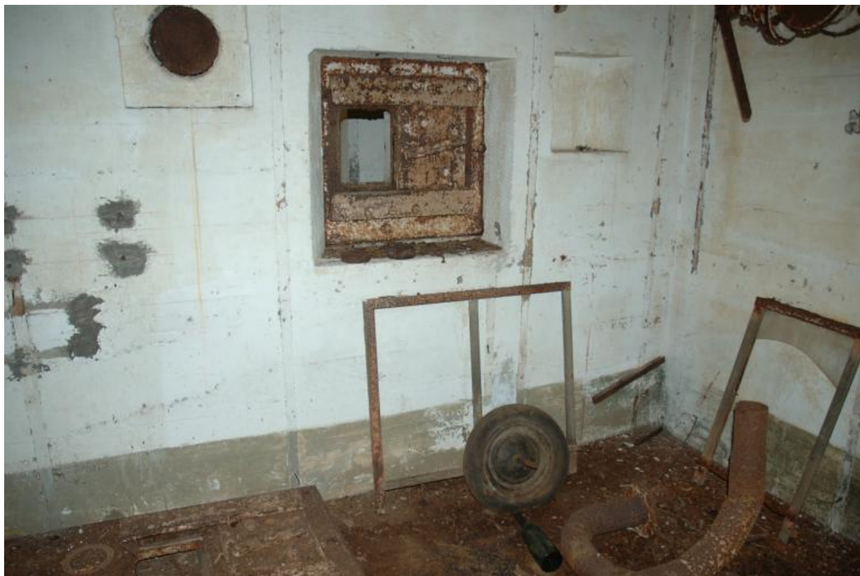
Vue de la chambre de troupe de gauche : créneau blindé de type 48P8 (état en 2005)
