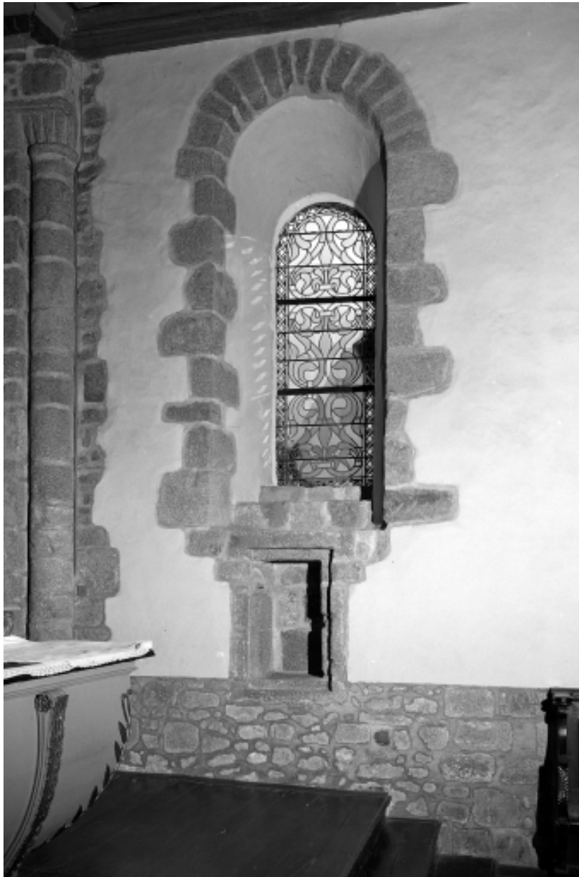
Intérieur, chœur, mur sud : vue générale.
