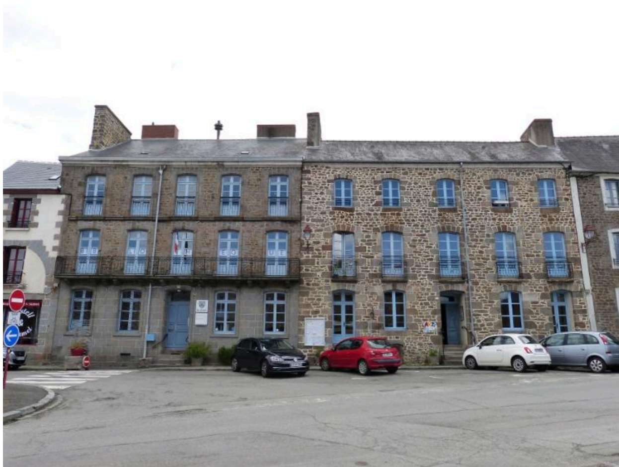
Vue de la façade ouest
