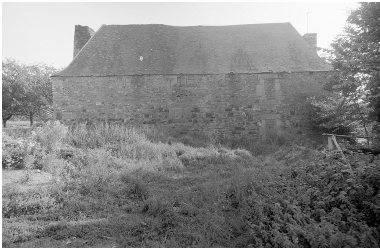
Vue de la façade nord
