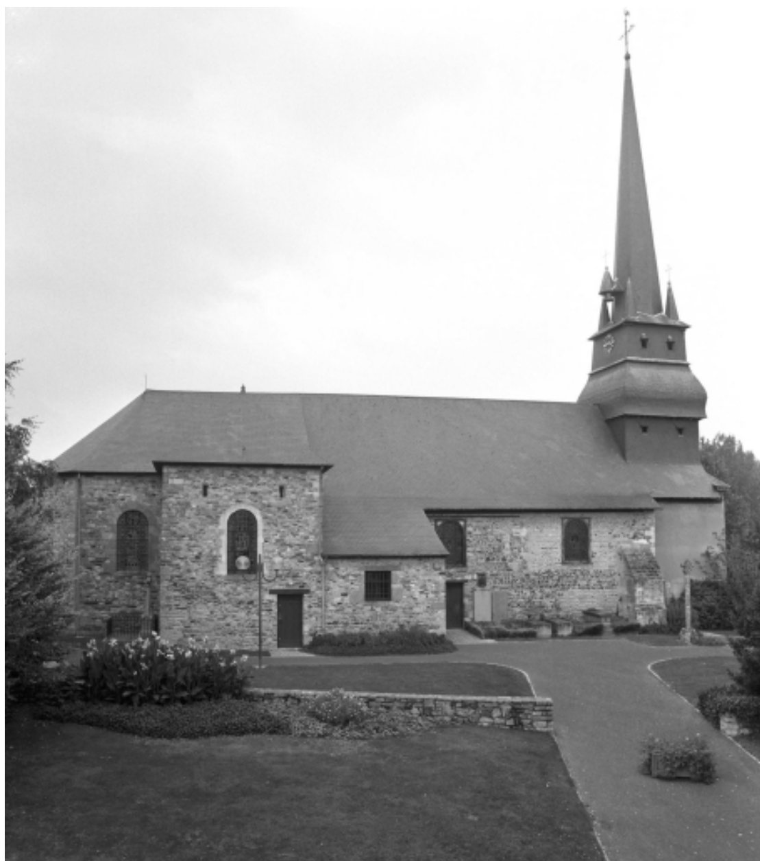
Vue d'ensemble de la façade sud
