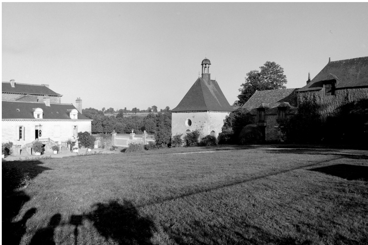
Cour intérieure, vue générale sud.
