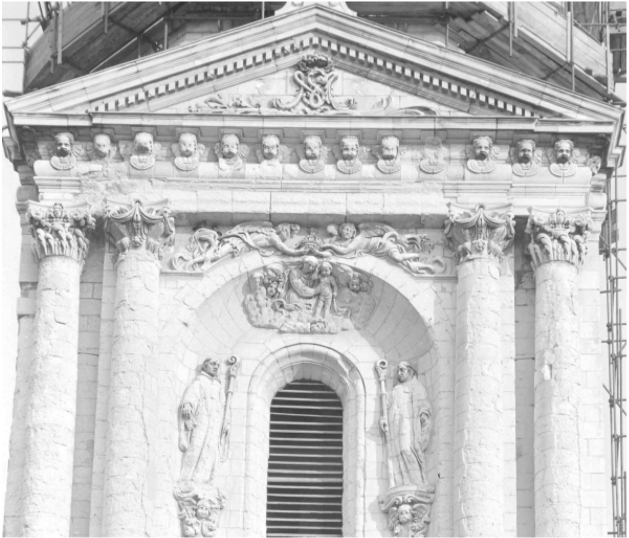
Elévation ouest du clocher, partie basse
