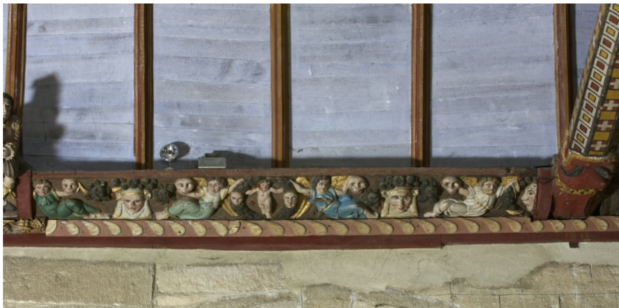
Intérieur, mur sud de la nef, détail de la sablière
