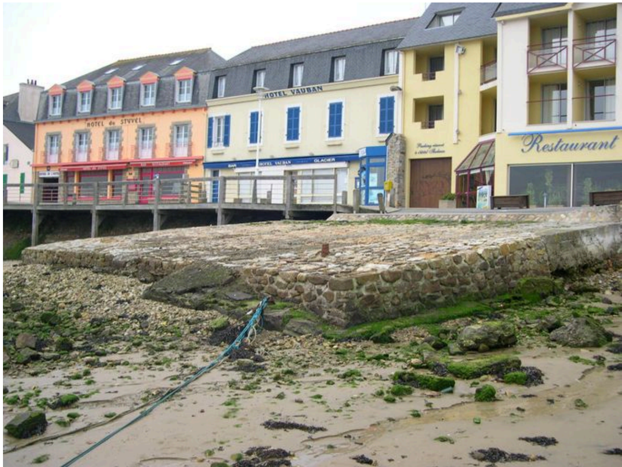
Vue générale de la cale du Styvel
