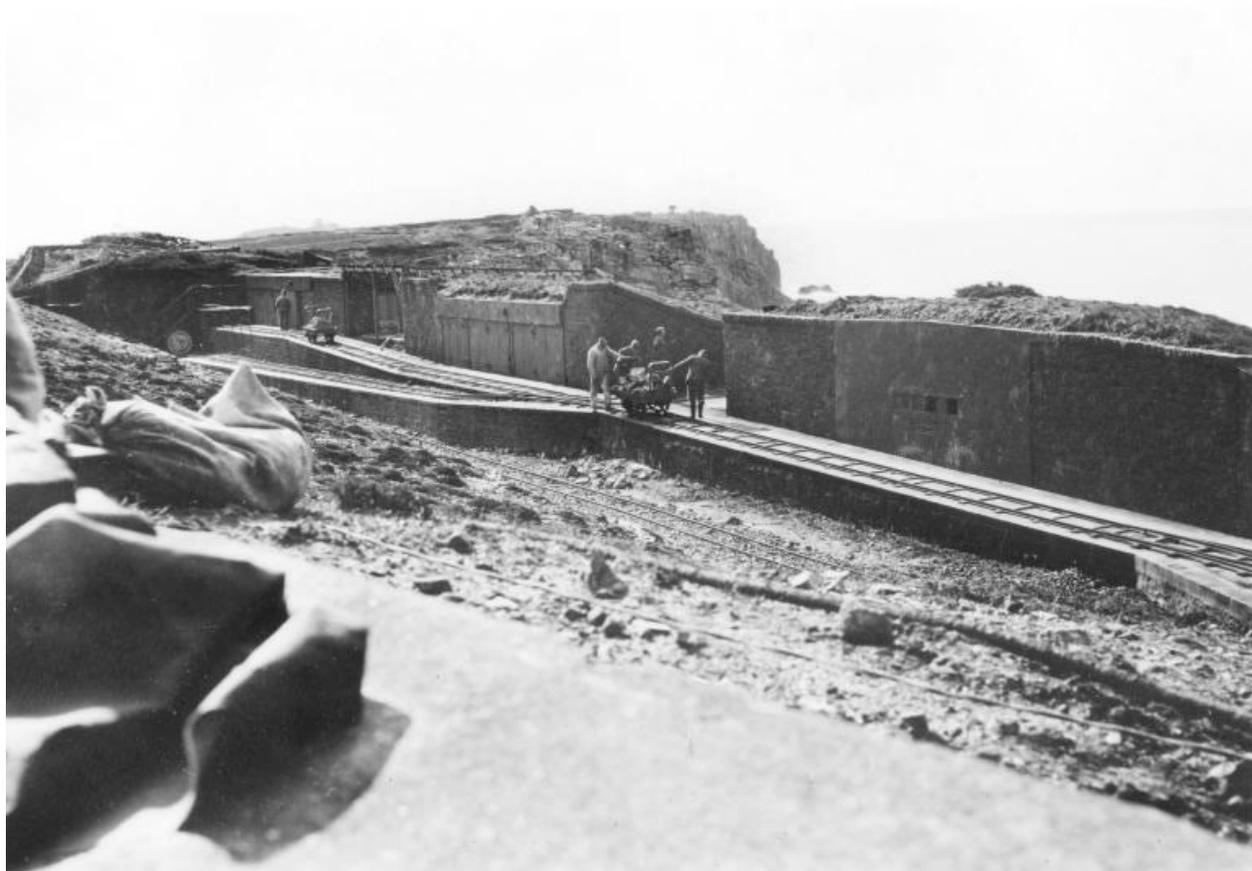
Vue de la batterie française de mortier. A l'extrême gauche, une des quatre pièces de 164,7 mm en cuve. Le transport des munitions (gargousses et projectiles) jusqu'à la pièce d'artillerie est facilité par les wagonnets sur voies étroites de 60 cm d'écartement (système Decauville)
