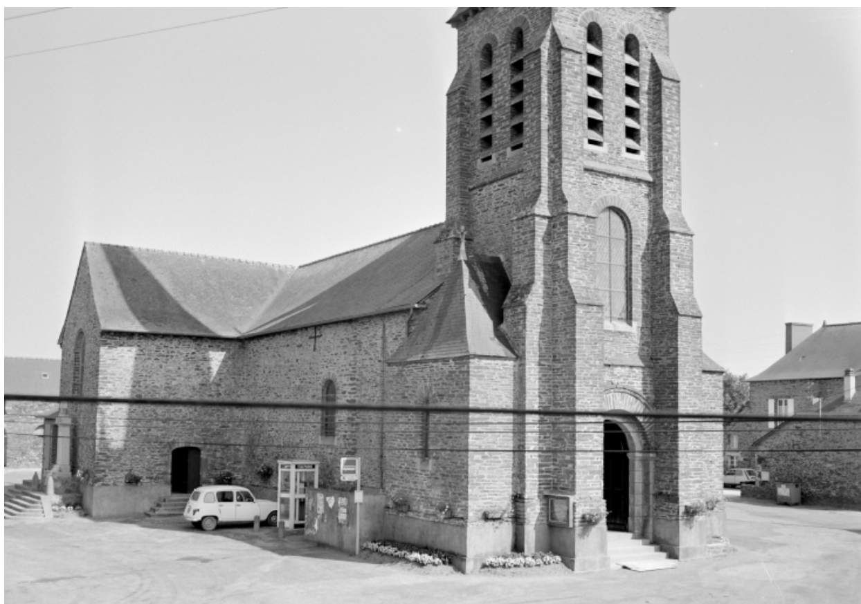
Elévation Ouest : vue générale.
