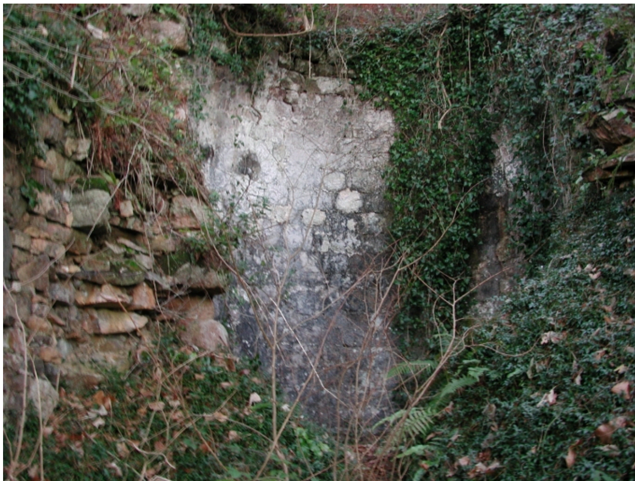
Vue du four à chaux, entouré de murs en ruine
