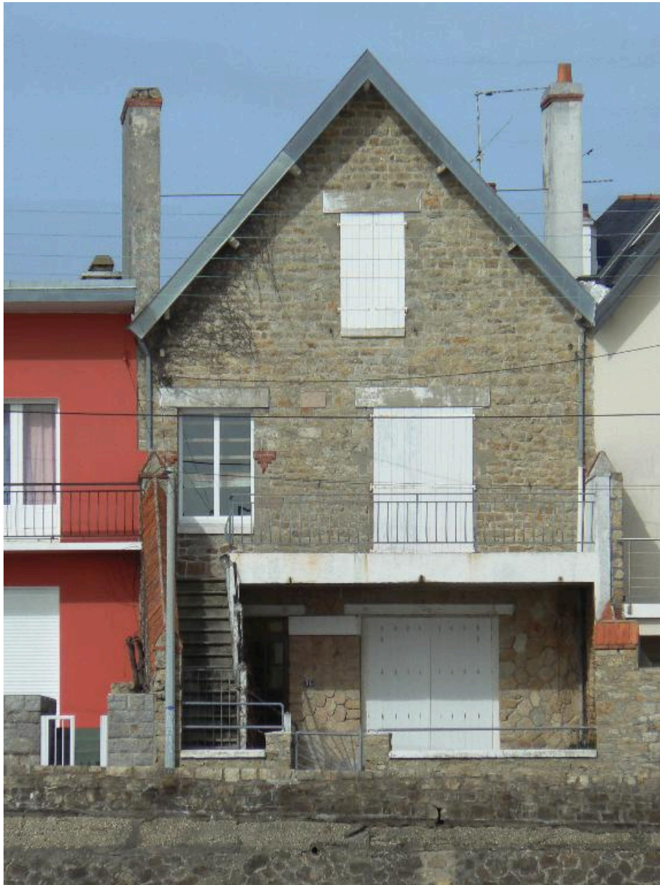
Vue générale de la maison de villégiature du 35 boulevard de la Nourriguel
